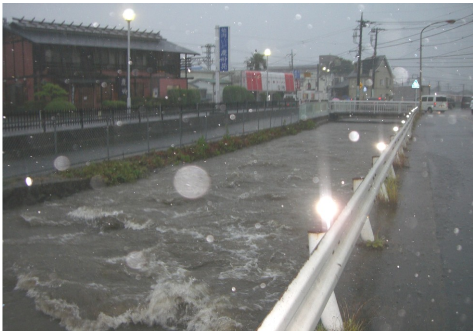
栢山駅方面 浸水のため駅周辺は通行止め
